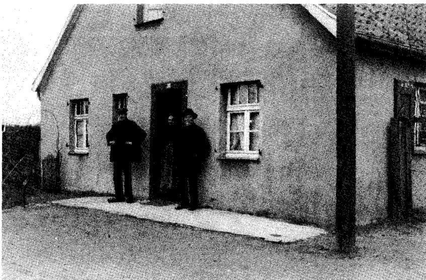
Neben dem Haus Am Merks stand das Haus des letzten Lintorfer Holzschuhmachers Johann Klotz (geb. 29.3.1855, gest. 15.9.1923). Johann Klotz, Frau Klotz (geb. Bergmann), ganz rechts: Bäckermeister Fritz Steingen. Aufnahme 1918
